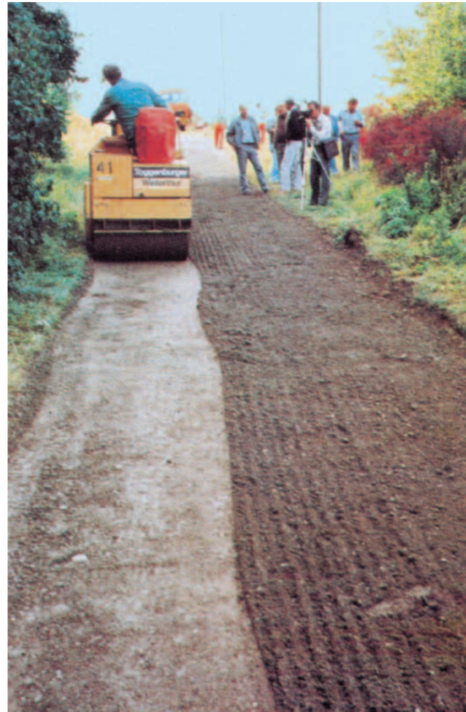
SONDRIO - Strada forestale. Compattazione finale della strada stabilizzata con GLORIT ® .
