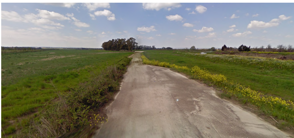
Figura 23 – strada esistente da rifunzionalizzare per uso ciclopedonale – tratto con piazzola di sosta da risagomare
