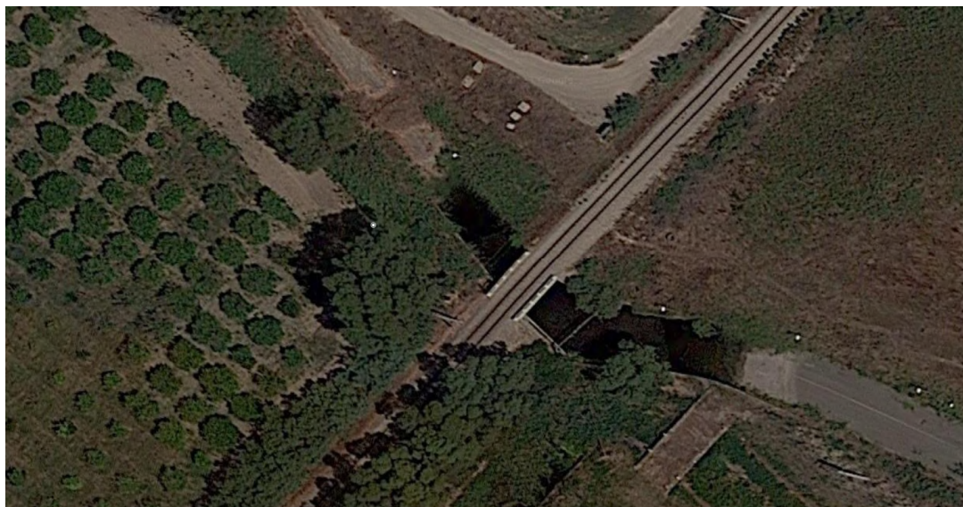
Figura 19 – sottopasso ferroviario esistente soggetto ad allagamento
