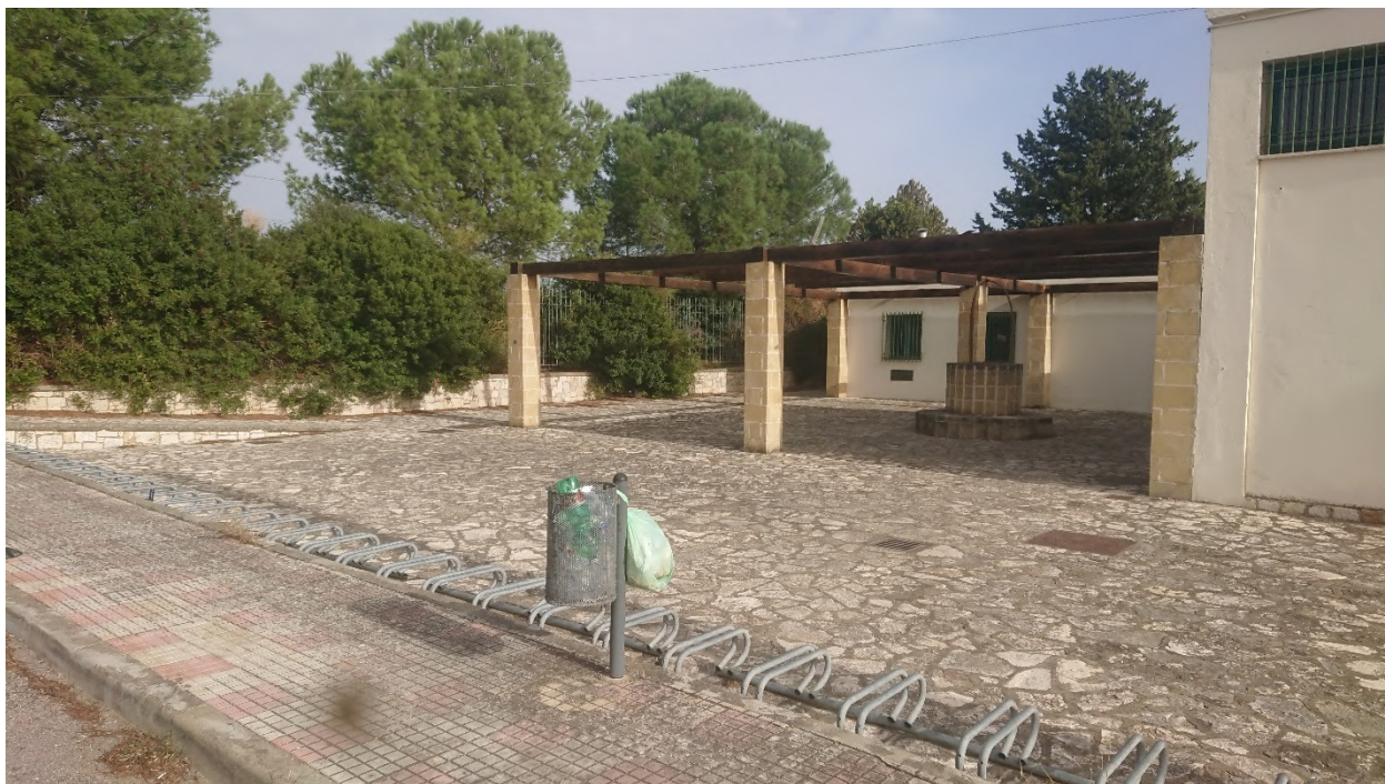
Figura 3 – Fotografia del marciapiede, delle rastrelliere e della struttura esterna esistente (da replicare in affiancamento)
