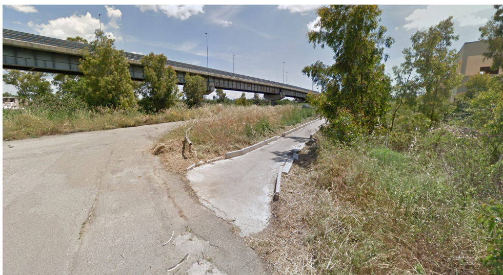
Figura 5 – Percorso pedonale esistente da adeguare
