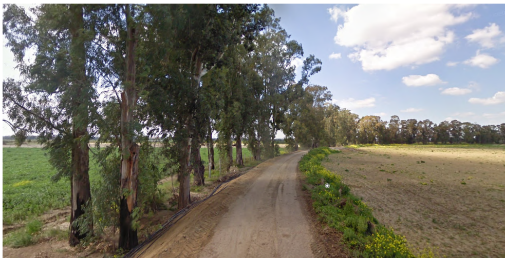
Figura 24 – strada esistente da rifunzionalizzare per uso ciclopedonale – tratto da risagomare
