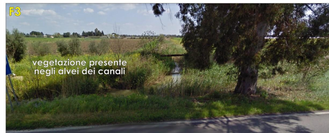
Figura 10 - Reticolo idrografico dell'area di intervento. Gli alvei dei corsi d'acqua risultano generalmente poco incisi (Foto 1) e soltanto a tratti sono riconoscibili degli argini ben definiti morfologicamente (Foto 2). Inoltre la scarsa manutenzione dei canali artificiali ha favorito la crescita della vegetazione che contribuisce a ridurre la funzionalità idraulica della rete di drenaggio (Foto 3).
