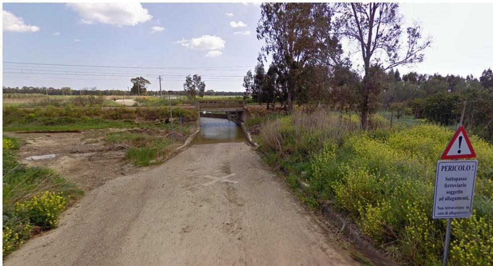
Figura 16 – Sottopasso ferroviario esistente allagato – foto Google street
