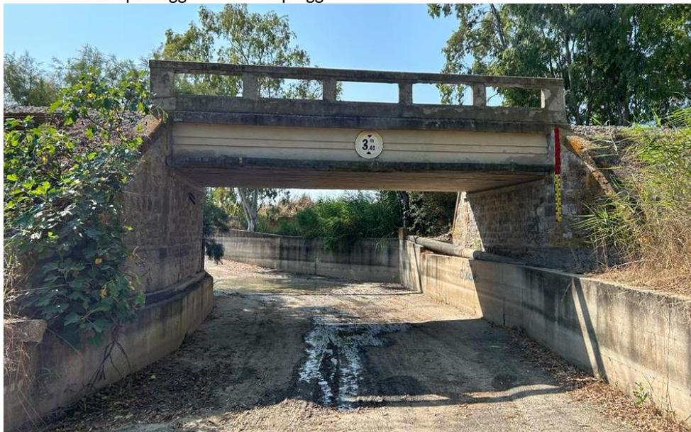
Figura 15 – Sottopasso ferroviario esistente con fanghiglia depositata sul fondo – sopralluogo giugno 2023
