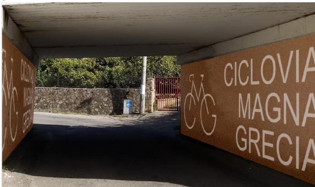
Figura 31 – Lastre in acciaio Corten per abbellimento dei sottopassi
