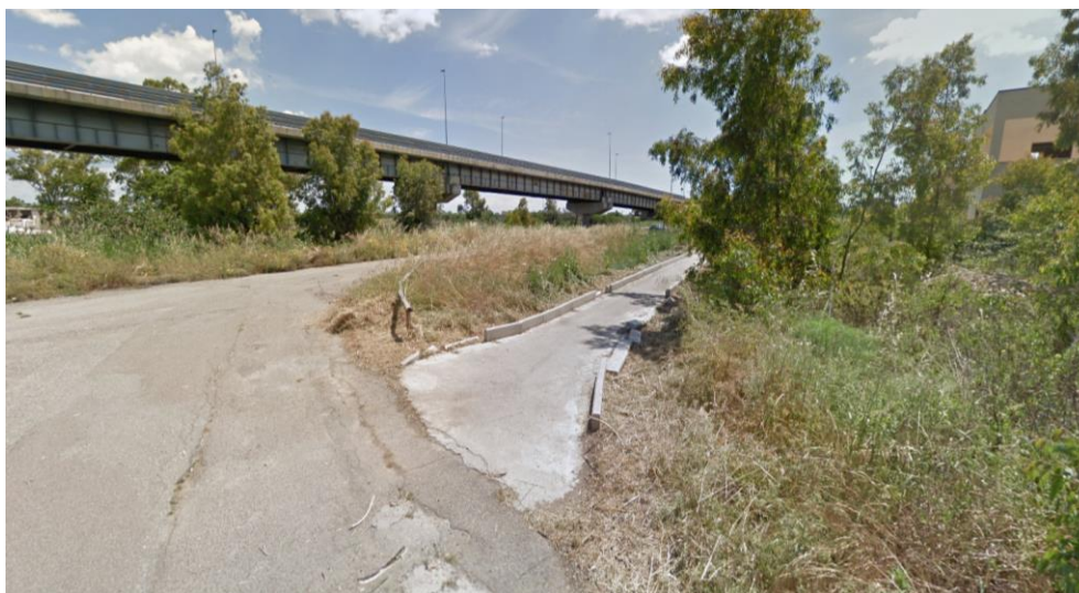
Figura 6 – Percorso pedonale esistente da adeguare
