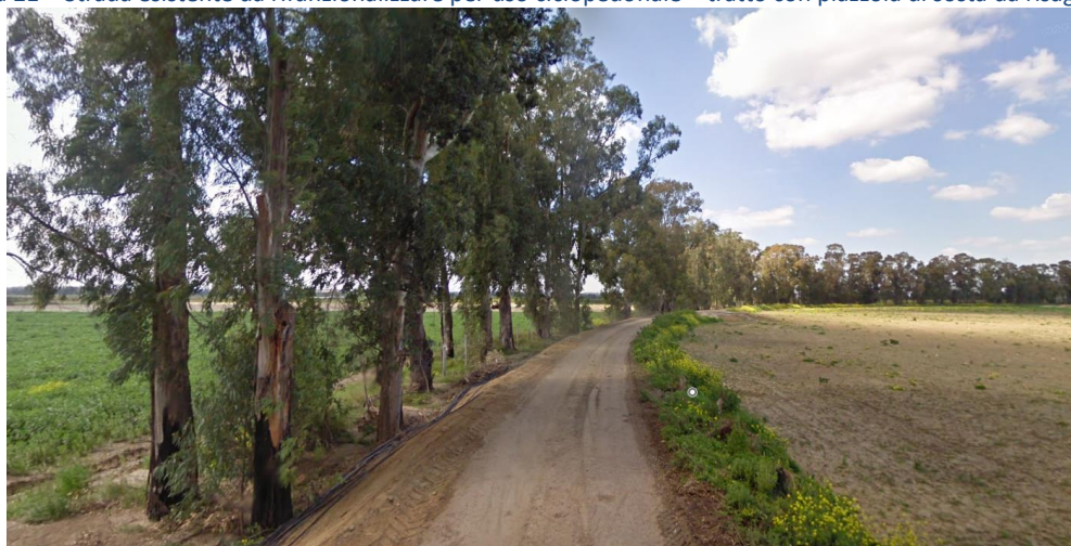
Figura 22 – Strada esistente da rifunzionalizzare per uso ciclopedonale – tratto da risagomare
