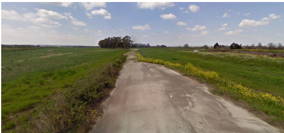
Figura 21 – Strada esistente da rifunzionalizzare per uso ciclopedonale – tratto con piazzola di sosta da risagomare
