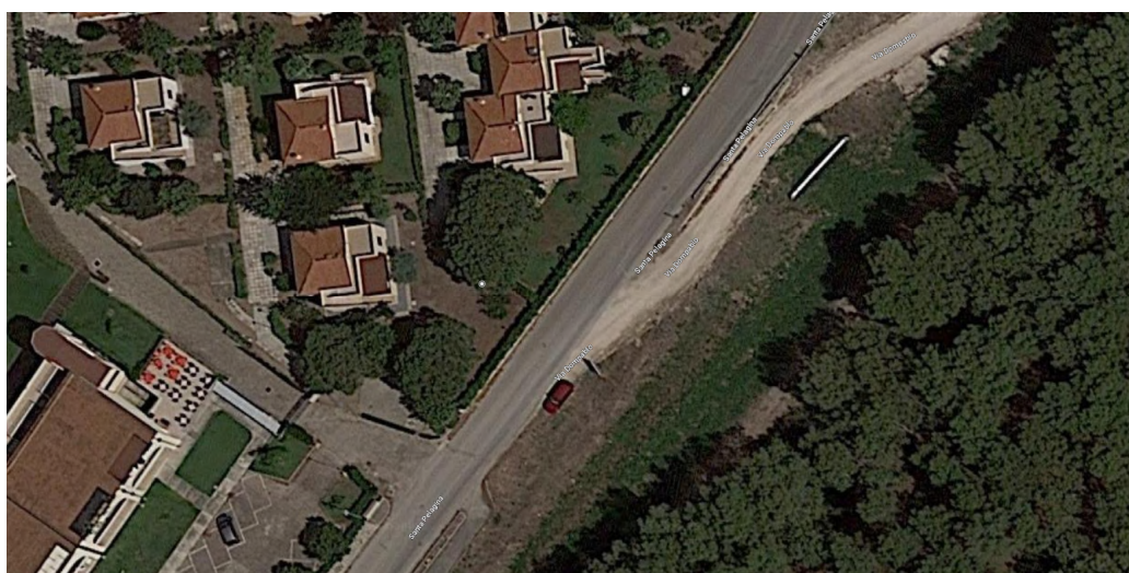
Figura 16 – fine del percorso pedonale/ciclabile adiacente alla Strada Comunale Santa Palagina e innesto su via Dompablo
