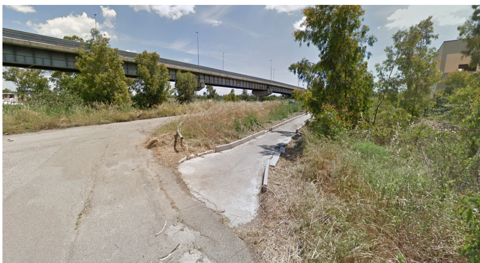
Figura 5 – Percorso pedonale esistente da adeguare
