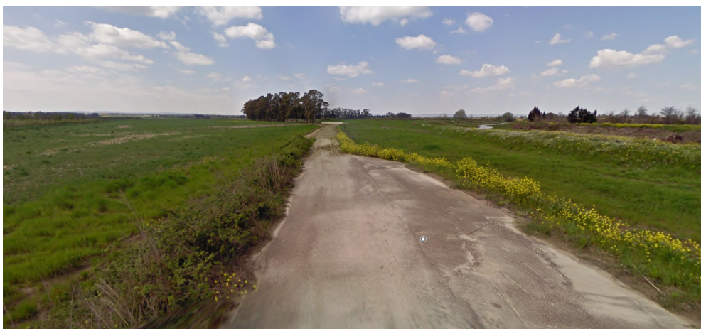
Figura 23 – strada esistente da rifunzionizzare per uso ciclopedonale – tratto con piazzola di sosta da risagomare
