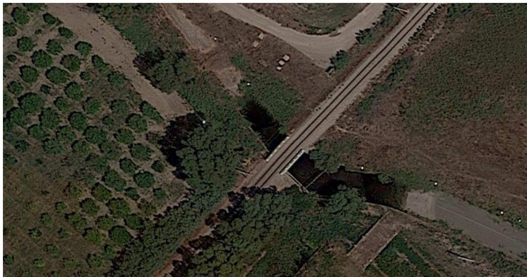
Figura 19 – sottopasso ferroviario esistente soggetto ad allagamento
