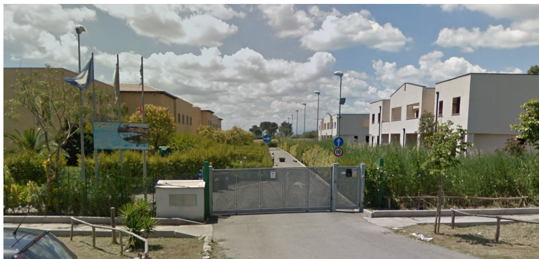
Figura 7 – Cancello di ingresso e manufatto impianti siti al lato del percorso pedonale esistente
