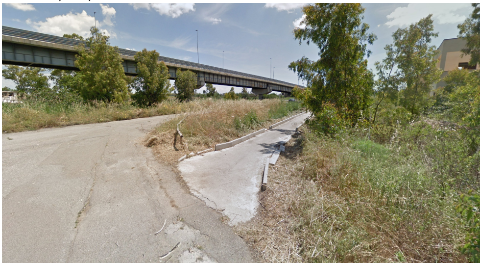
Figura 2 – Percorso pedonale esistente da adeguare
