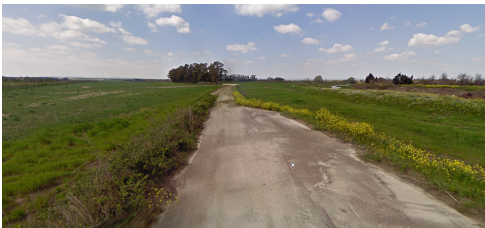
Figura 20 – strada esistente da rifunionalizzare per uso ciclopedonale – tratto con piazzola di sosta da risagomare
