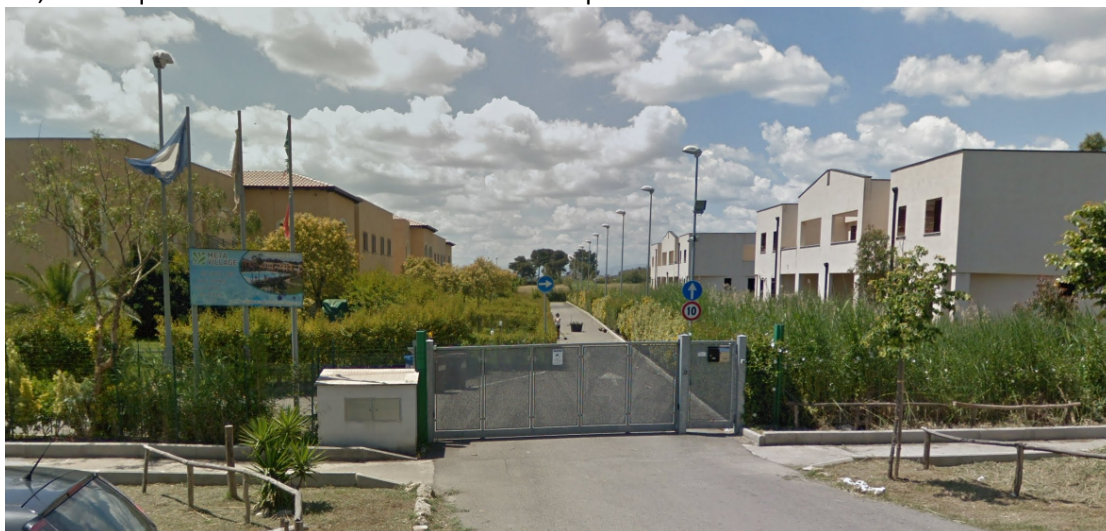
Figura 4 – Cancelli di ingresso e manufatto impianti siti al lato del percorso pedonale esistente
