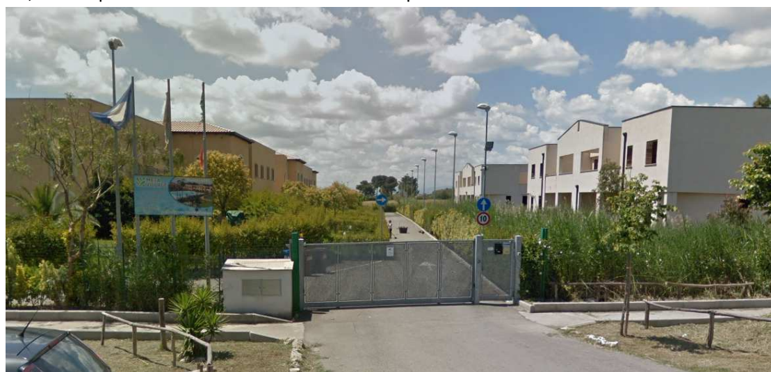
Figura 4 – Cannello di ingresso e manufatto impianti siti al lato del percorso pedonale esistente
