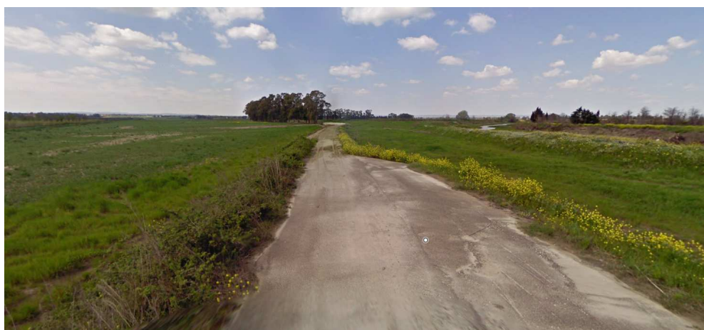
Figura 19 – strada esistente da rifunzionalizzare per uso ciclopedonale – tratto con piazzola di sosta da risagomare
