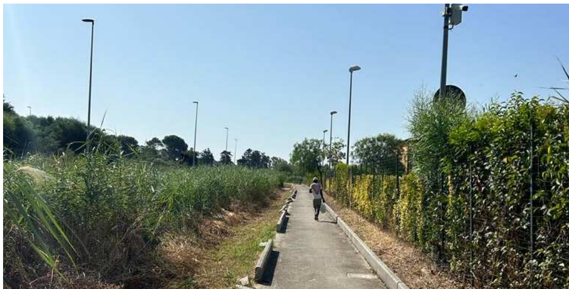
Figura 3 – Percorso pedonale esistente da adeguare
