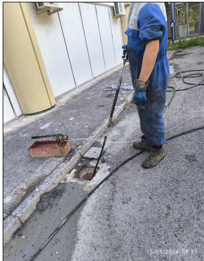
Particolare del sistema di iniezione – punta di iniezione
