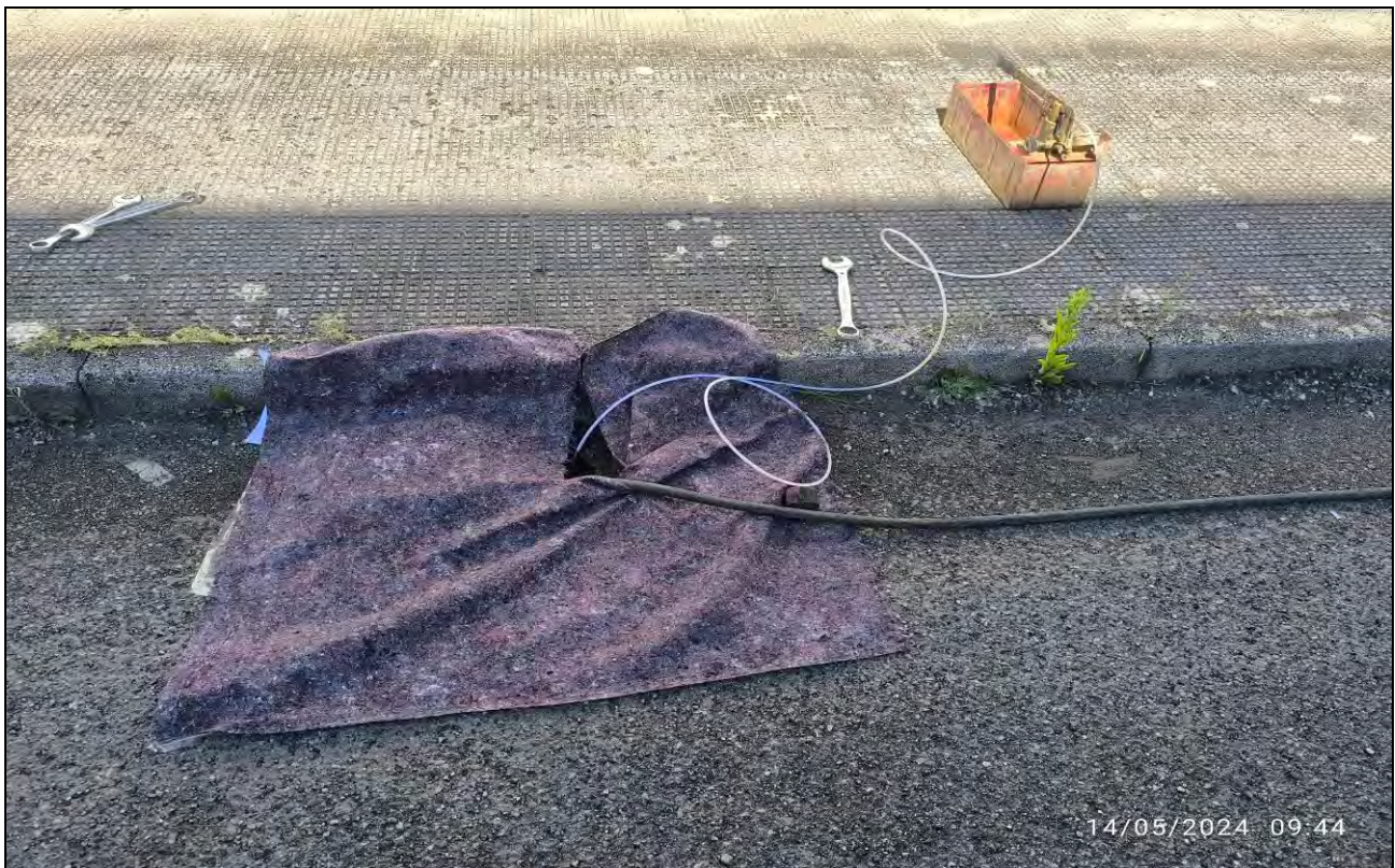
Particolare del sistema di iniezione – pressurizzazione doppio packer
