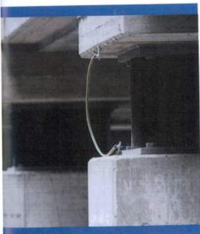
Foto 6 – Il sistema di isolamento alla base
