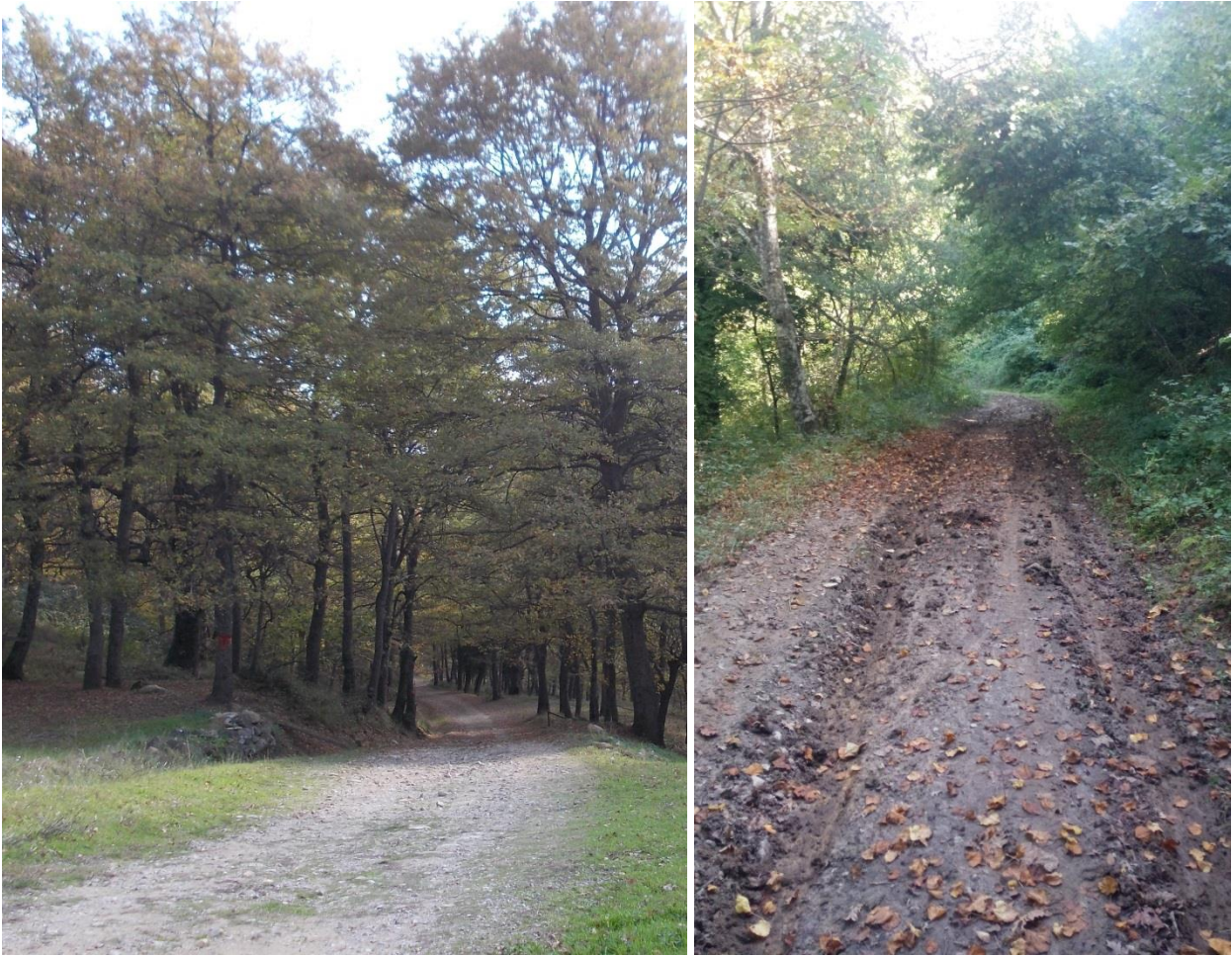
Foto 6: Esempi tratti di strada camionabile secondaria (a sinistra) e trattorabile (a destra)
