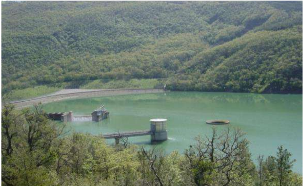
Figura 14 diga di Ponte Fontanelle sul Torrente Camastra - Trivigno
